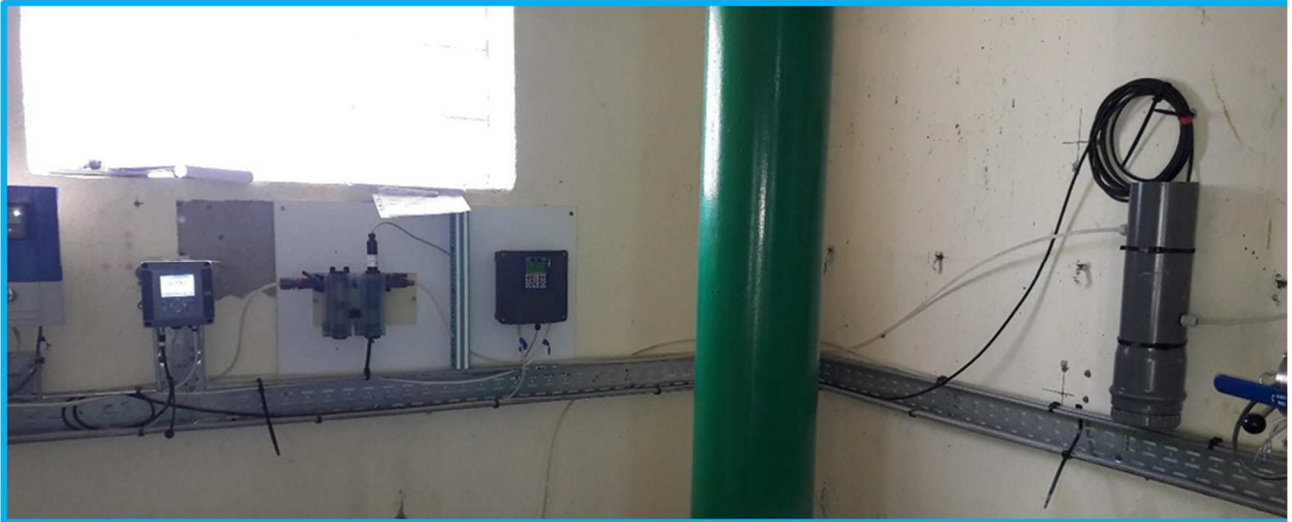
St Hilaire de Beauvoir – Pompage du Peillou : Turbidimètre et installation associée
