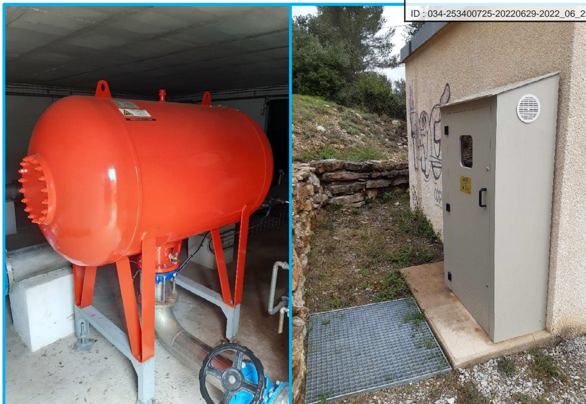
Pompage Fontbonne Mougères : Ballon anti-bélier et armoire stockage de chlore
